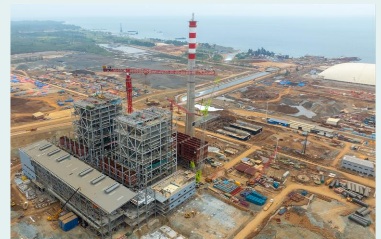
Pembangkit Listrik 1x380 MW untuk menunjang proyek KPS (akhir Mei, 2024 - 42% selesai)
