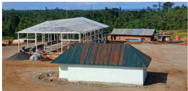
Progress pembangunan lokasi Tempat Pembuangan Sampah Terpadu desa Kawasi. Progress of the construction of the Integrated Waste Disposal Site in Kawasi Village.
