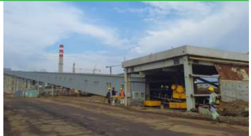
Sistem Ban Berjalan di HJF untuk menggantikan penggunaan kendaraan berat
